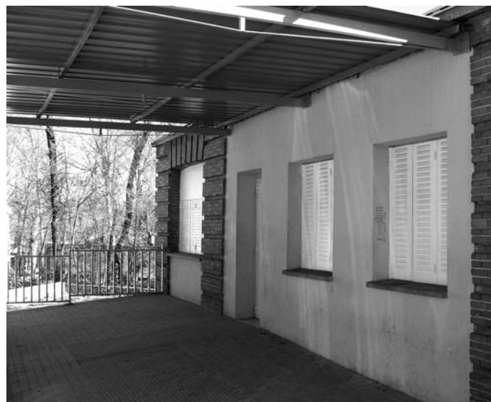
Exterior del pabellón de servicios de Mayoreales.
